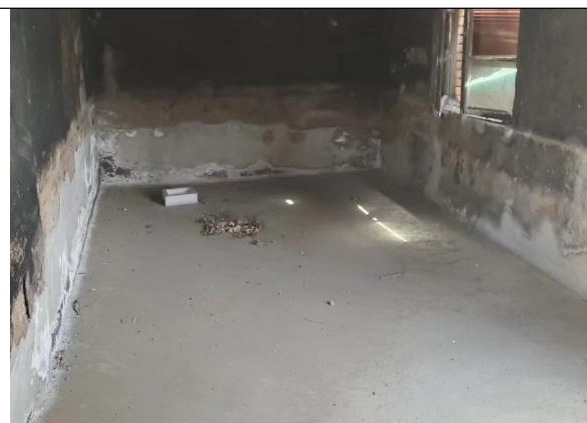
危险废物暂存间地面及墙裙防渗
