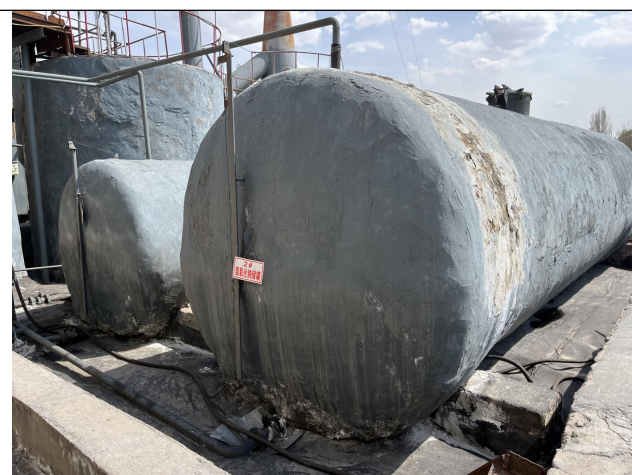
液碱储罐区围堰
