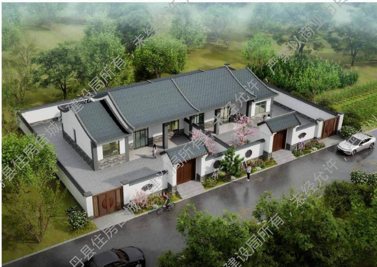
该方案设计建筑风格以“明清清雅风格”为主，建筑色彩以白、灰色，青色为主。总体设计兼顾农房的美观性、舒适性和经济性，可毗邻拼接布局极大的降低了建造成本。屋面为卷棚双坡屋面，设置青灰色树脂瓦，主屋屋面与次卧屋面高低错层设计。入户口为开敞通廊，后期也可以玻璃暖廊封闭。白色主体墙面，条石贴面墙裙；墙角、柱体灰色漆面。围墙布局规整，铺以用砖做研磨拼图造型和青灰色砖面踢脚。设置独立车行出入口。大门、门柱材质细节考究，门头为双坡门头，大门为赭石色木质大门。建筑整体有“简练、清雅、精致”之感。
