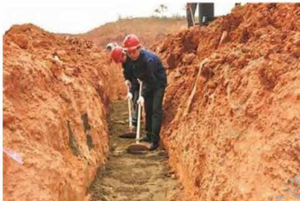
基底挖除湿陷性黄土后回填灰土垫层
