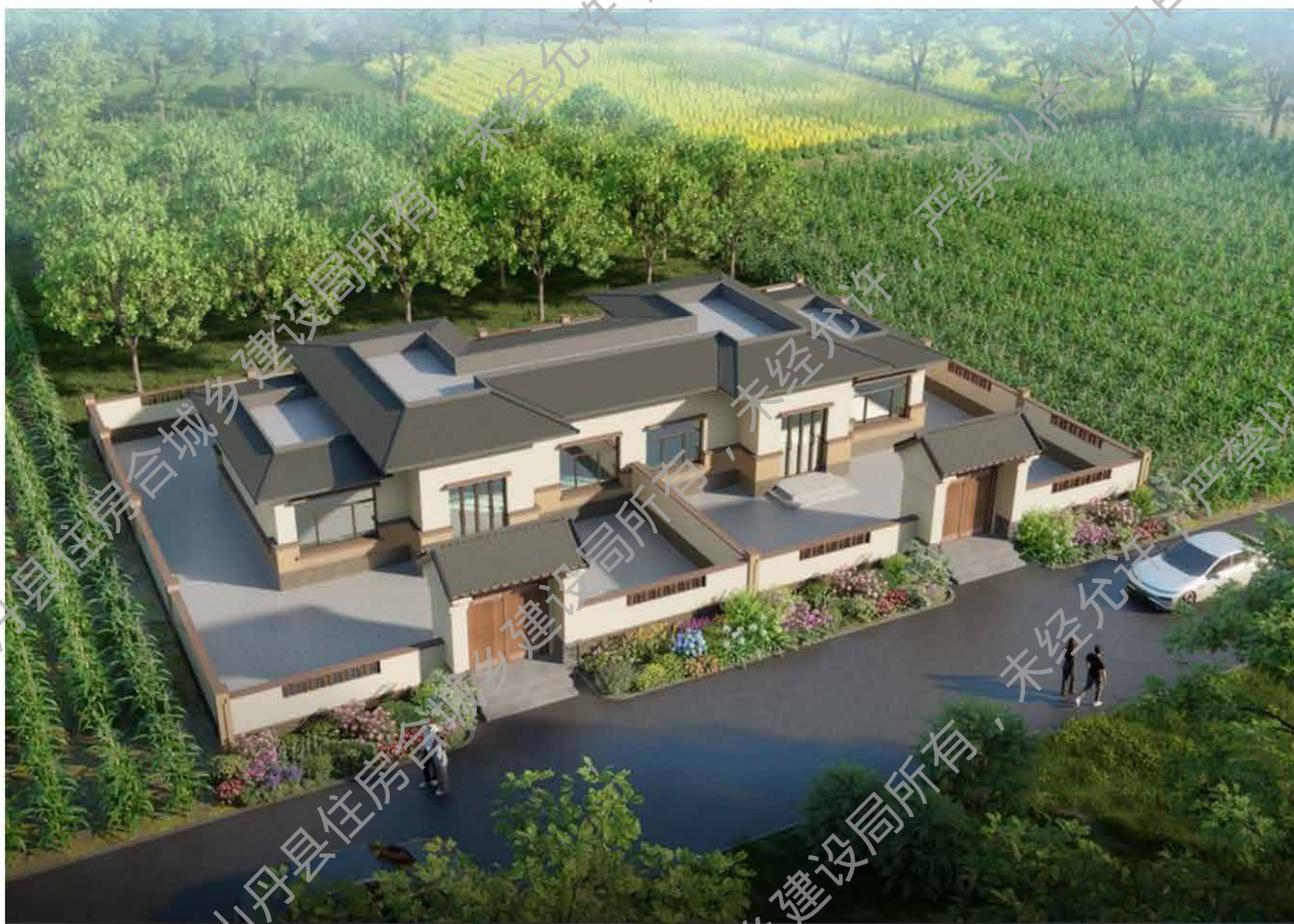
该方案设计建筑风格以“汉唐清雅风格”为主，建筑色彩以白、灰色，土黄色为主。总体设计兼顾农房的美观性、舒适性和经济性，可毗邻拼接布局极大的降低了建造成本。屋面为唐式四坡挑檐屋面，设置青灰色树脂瓦，主屋屋面与次卧屋面高低错层设计。白色主体墙面，卵石堆砌墙裙；墙裙与窗沿之间加以粗面土黄色真石漆。使得整个建筑更有层次感，建筑立面简约而不单调。院墙规整布局，局部镂空，以木质构件有序填充，围墙踢脚为灰色水泥。大门、门柱材质细节考究，门头为双坡门头，建筑整体有“大气、浑厚、严整”之感。
