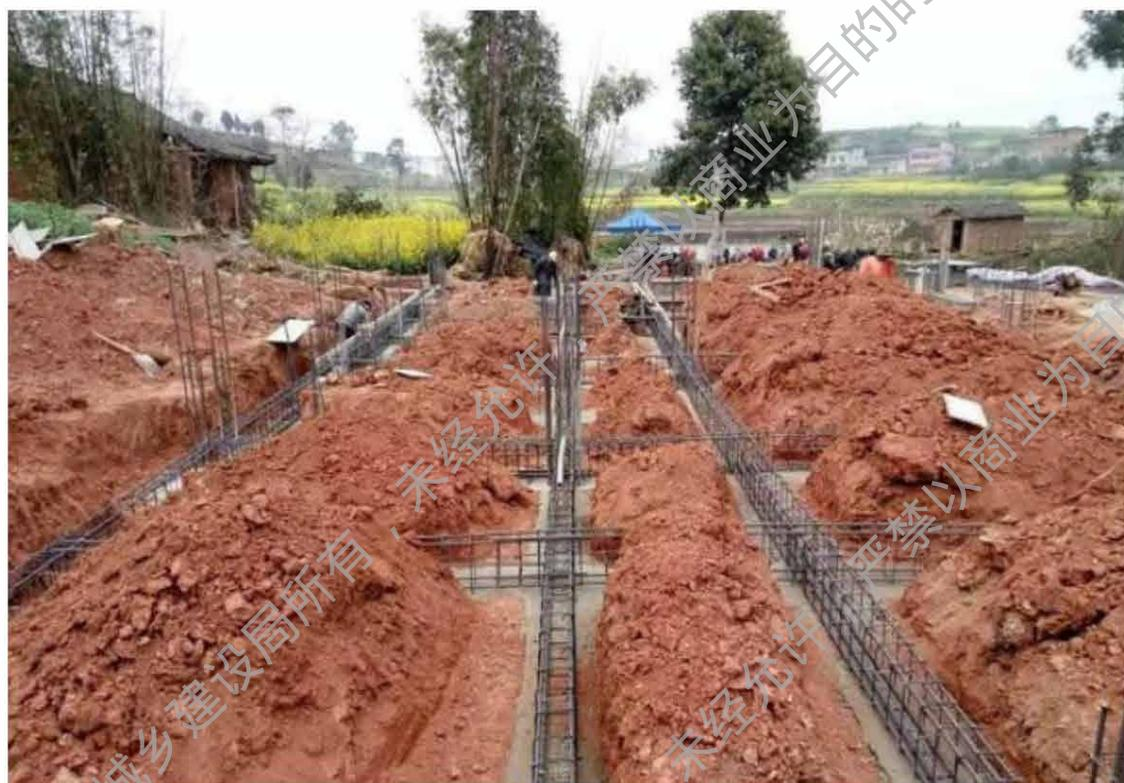
混凝土条形基础钢筋绑扎
