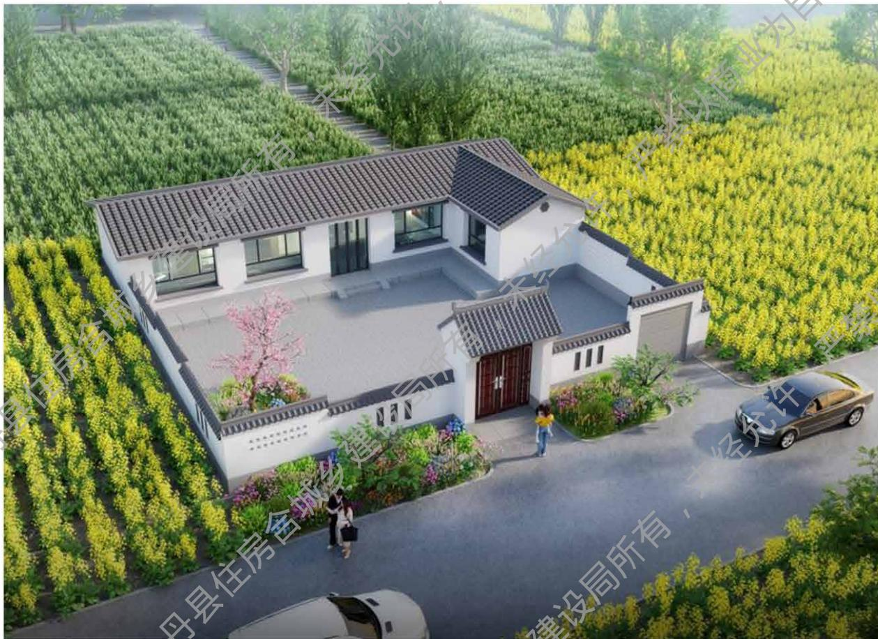
该方案设计以传统元素与现代风格相结合，建筑风格以“明清清雅风格”为主，建筑色彩以青、灰、白色为主。本案采用传统四合院式布局，既可以独立成栋，又可做毗邻视拼接，房屋平面呈“L”字形，布局整齐，封闭式连廊紧密联系各功能空间。屋面为硬山双坡屋面，屋面材质为传统小青瓦，主屋屋面与次卧屋面人字形交错。主体建筑白色墙面，灰色水泥墙裙。围墙围墙设计高低错差、局部镂空，以传统材料瓦片有序填充的院墙，灰色水泥踢脚。设置独立车行出入口。大门门头为双坡门头，大门为赭石色大门。建筑整体有“简练、清雅、精致”之感。
