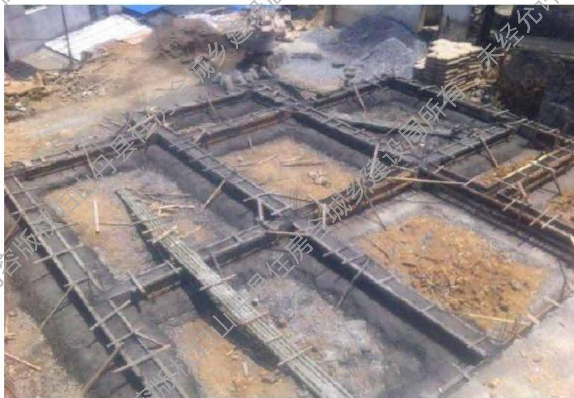
混凝土条形基础支模浇筑
