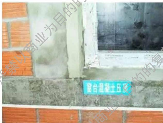
窗台混凝土压顶防水
