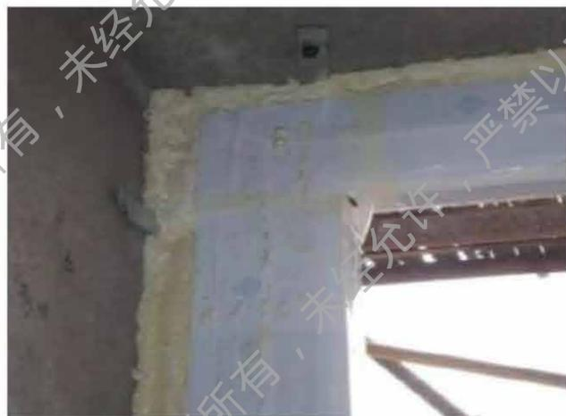
门窗框塞缝填密封胶
