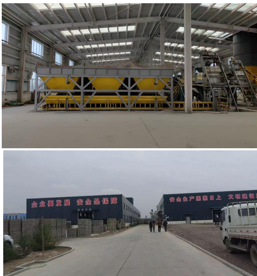
图 8-1 建筑垃圾资源化利用中心现状图
